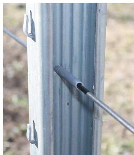
Установка троса через пластиковый дюбель
