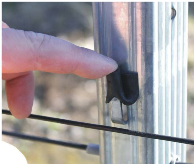
Установка защитного кембрика
