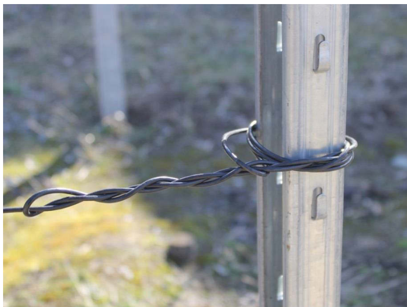
Крепление шпалерного троса к крайним столбам.
