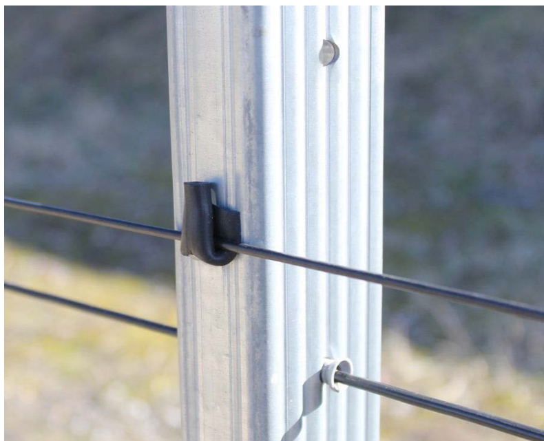
Шпалерный трос, закрепленный в проушине промежуточного столба
